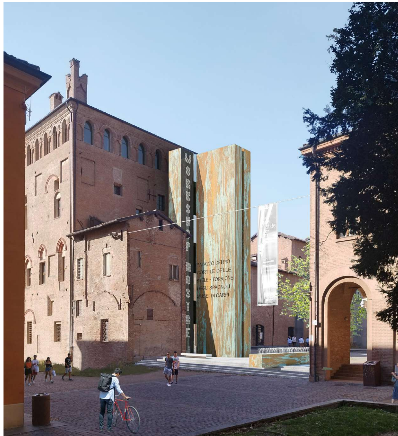
Vista della nuova scala dal giardino pubblico
