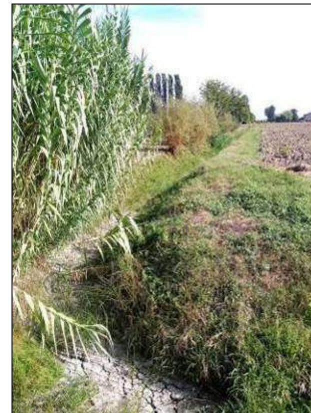
Foto 7 – il principio dello Scolo Gavasseto con vista verso nord
