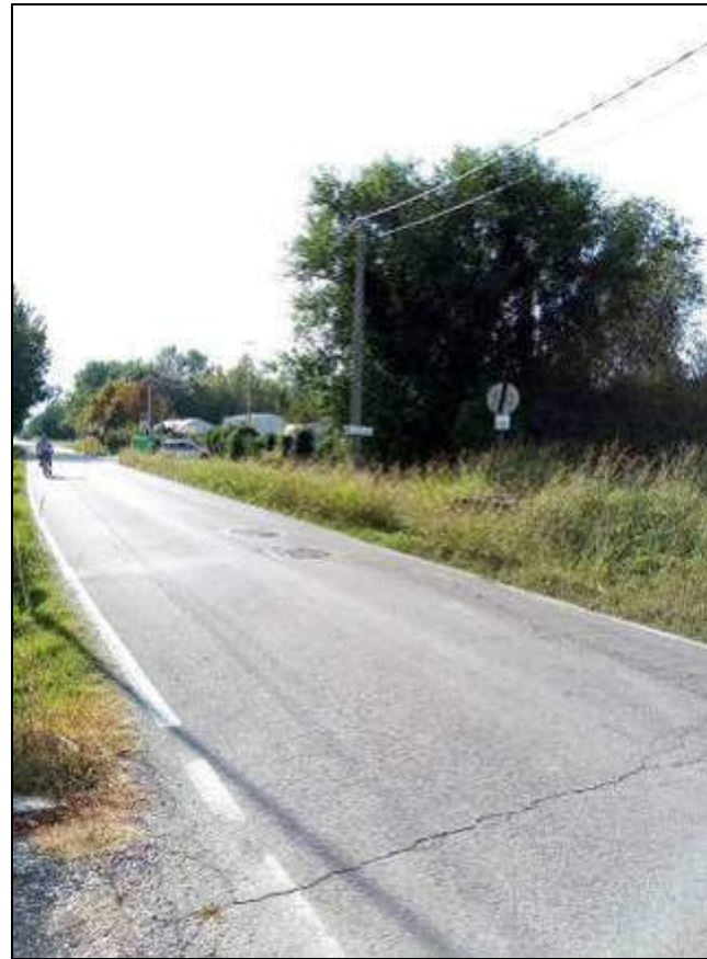
Foto 9 – vista verso sud-est lungo via Martinelli
