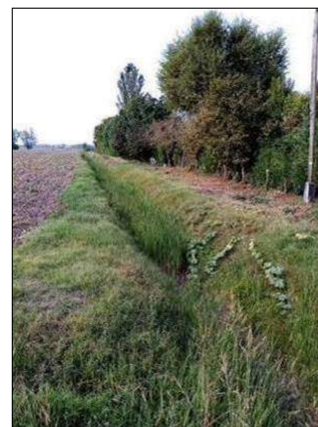
Foto 8 – lo Scolo Gavasseto verso sud visto da via Martinelli
