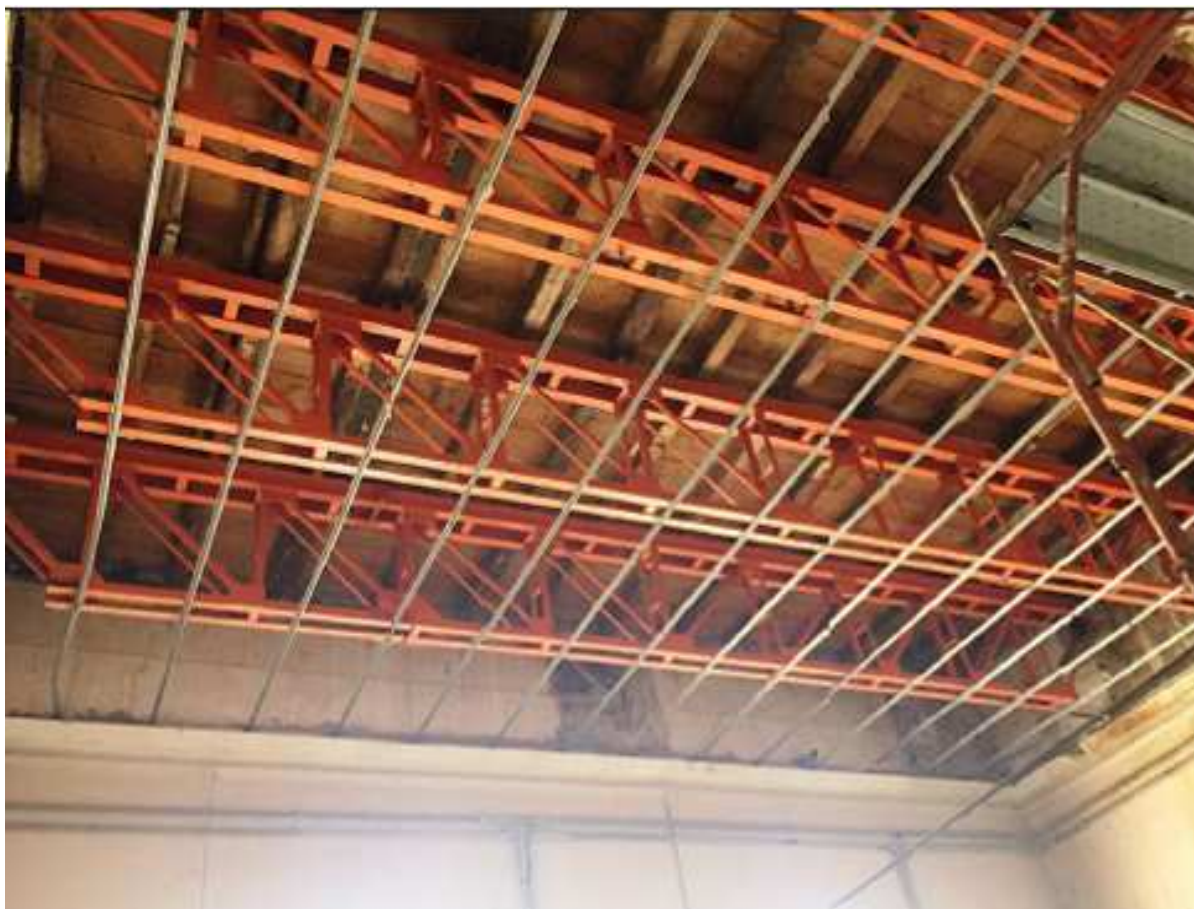
Immagine della parte ovest con tavolato prima dell'inizio dei lavori
