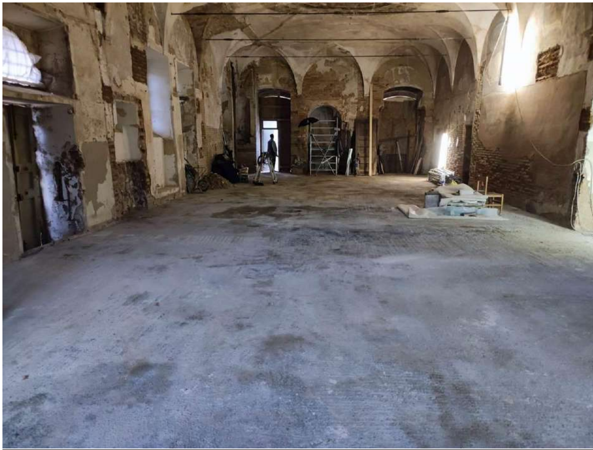
Fig. 12 - Vista d'insieme post interventi prospetto est – sala dello Zodiaco
