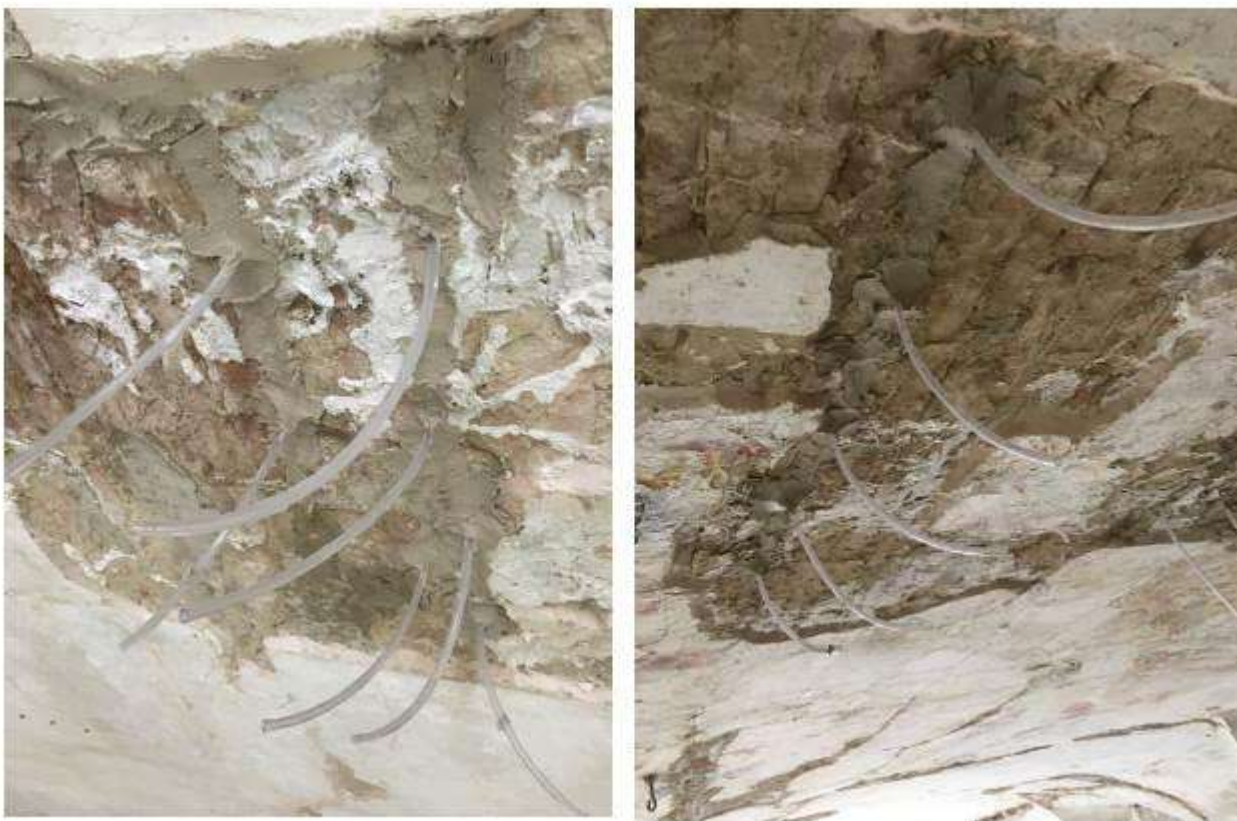
Fig. 9 - Stuccatura lesioni e posa tubetti iniettori
