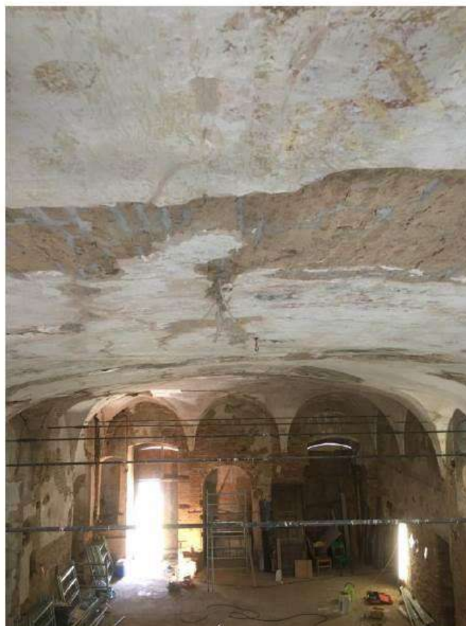
Fig. 11 - Vista d'insieme dell'intervento eseguito
