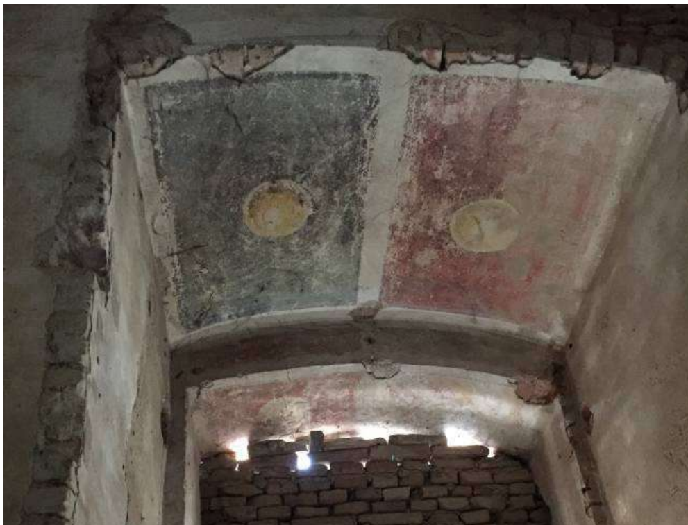
architrave ad arco decorato già visibile nell'apertura a nord
