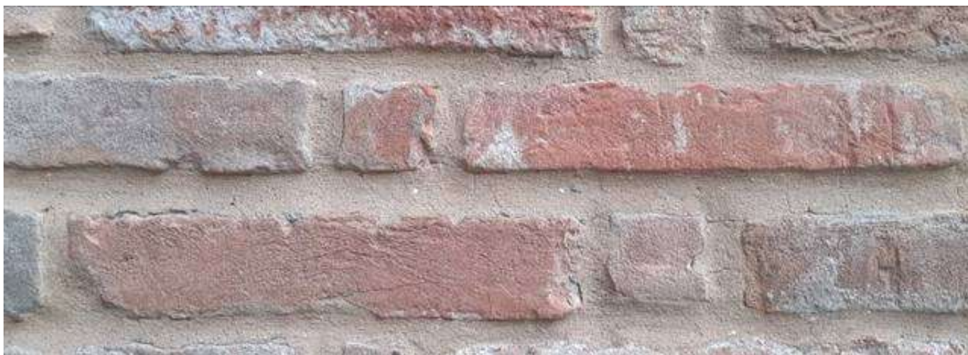
Immagine di dettaglio velatura a base di acqua di calce
