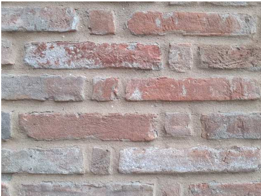
Campione velatura a base di acqua di calce
