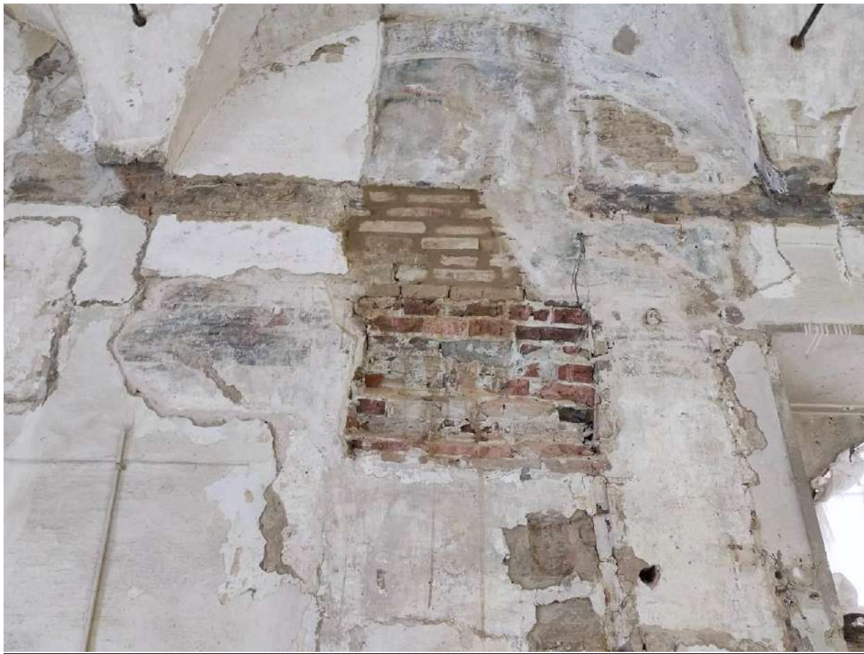
Fig. 20 – Dettagli scuci cuci parete nord – sala dello Zodiaco
