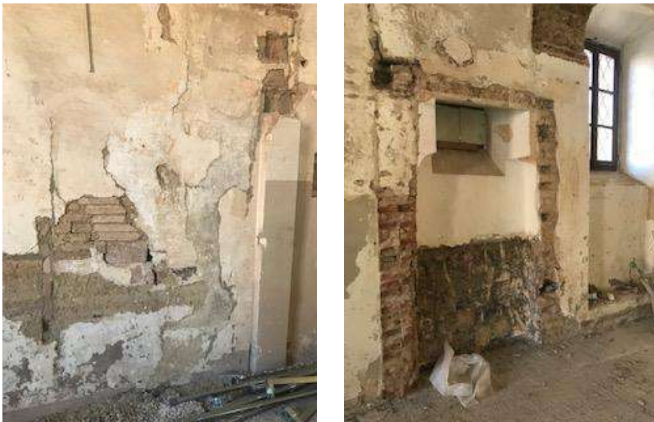
Fig. 14 – Dettagli scuci cuci parete nord – sala dello Zodiaco
