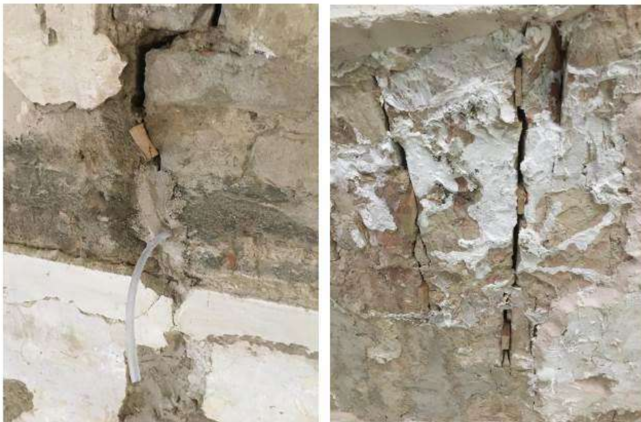
Fig. 8 - Inserimento cunei in legno duro
