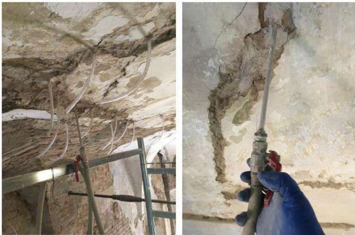
Fig. 10 - Iniezione delle lesioni
