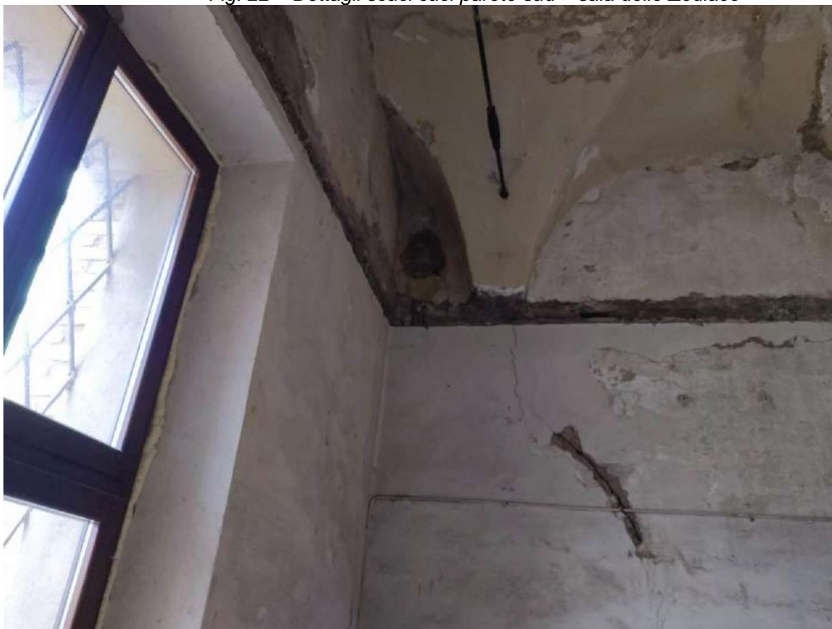
Fig. 23 – Dettagli scuci cuci parete nord-ovest – sala dello Zodiaco
