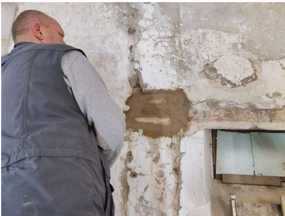
Fig. 19 – Dettagli scuci cuci parete nord – sala dello Zodiaco
