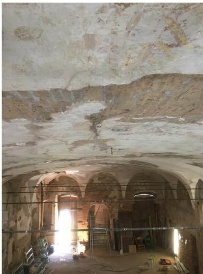
Fig. 11 - Vista d'insieme dell'intervento eseguito
