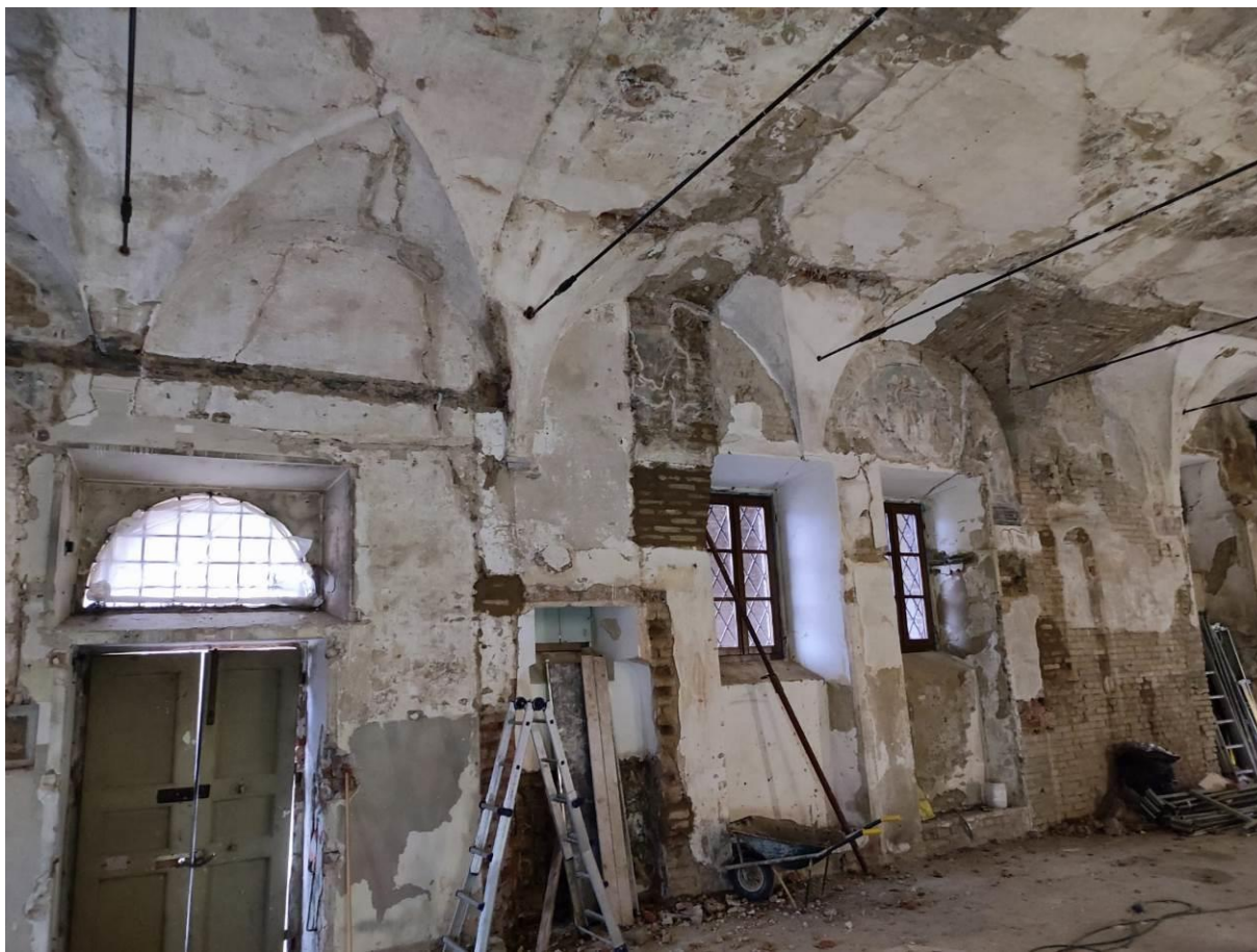
Fig. 15 – Dettagli scuci cuci parete nord – sala dello Zodiaco
