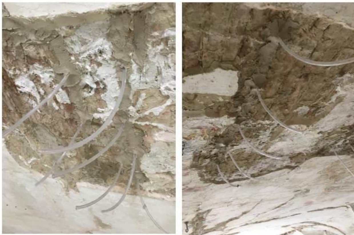
Fig. 9 - Stuccatura lesioni e posa tubetti iniettori
