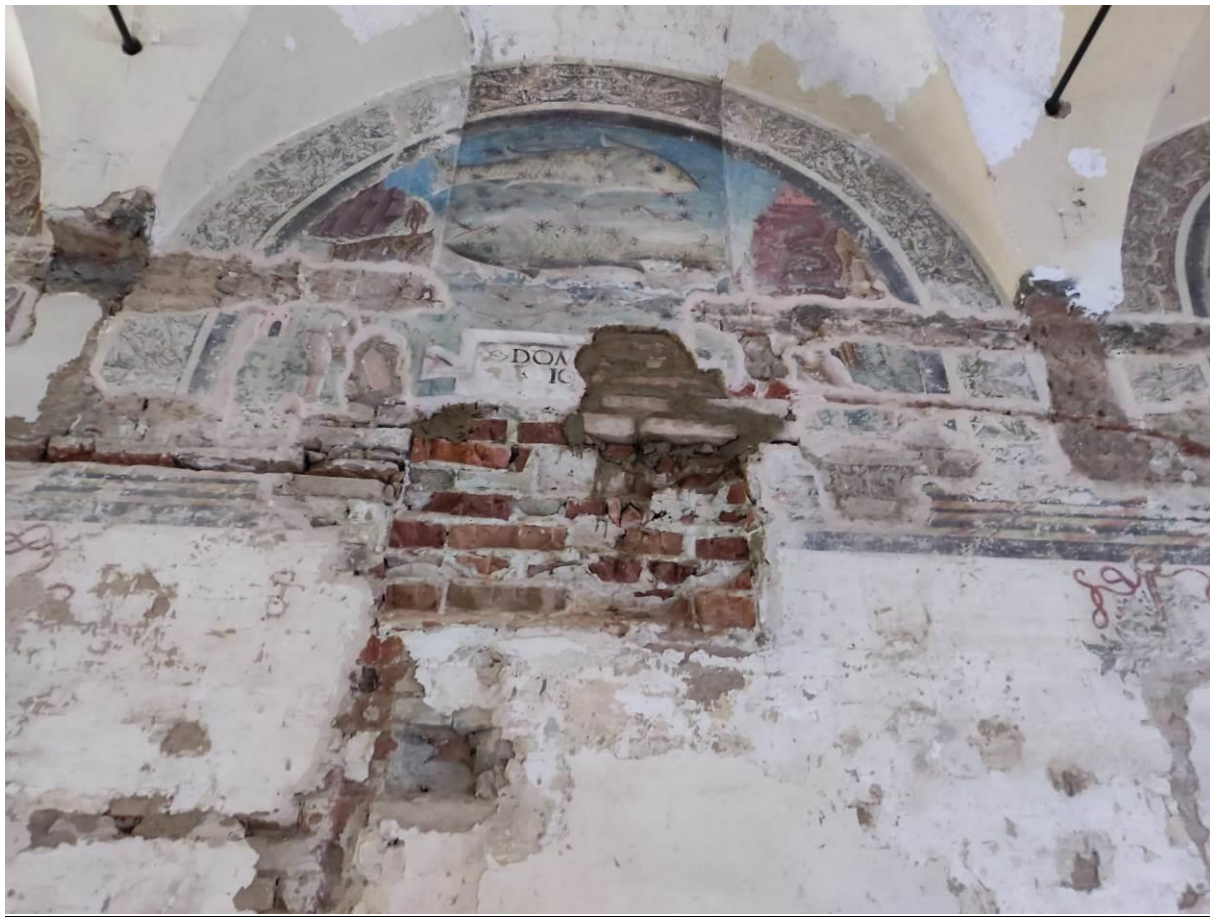
Fig. 22 – Dettagli scuci cuci parete sud – sala dello Zodiaco
