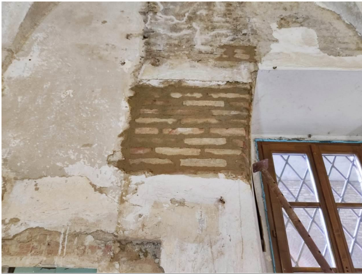
Fig. 18 – Dettagli scuci cuci parete nord – sala dello Zodiaco
