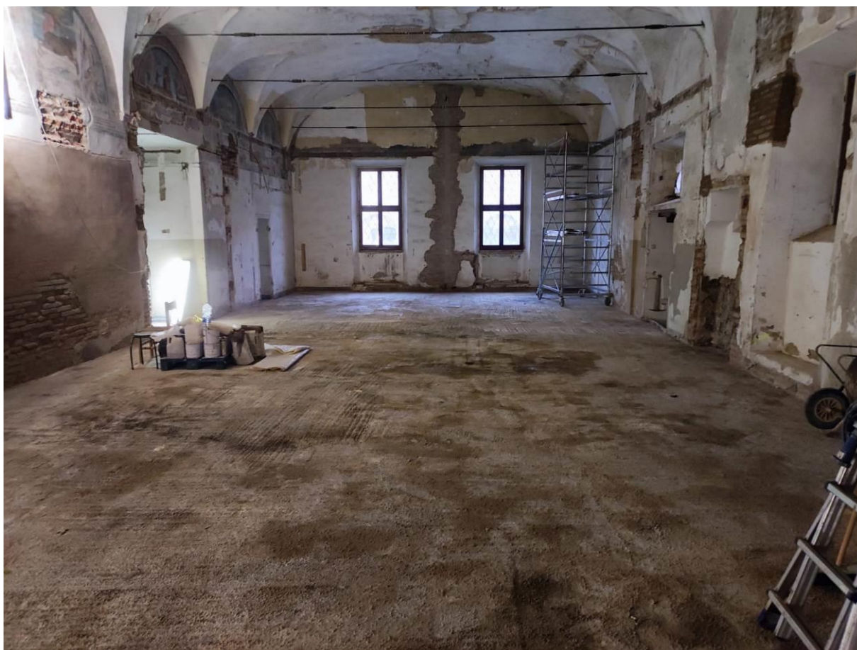
Fig. 13 - Vista d'insieme post interventi prospetto ovest – sala dello Zodiaco
