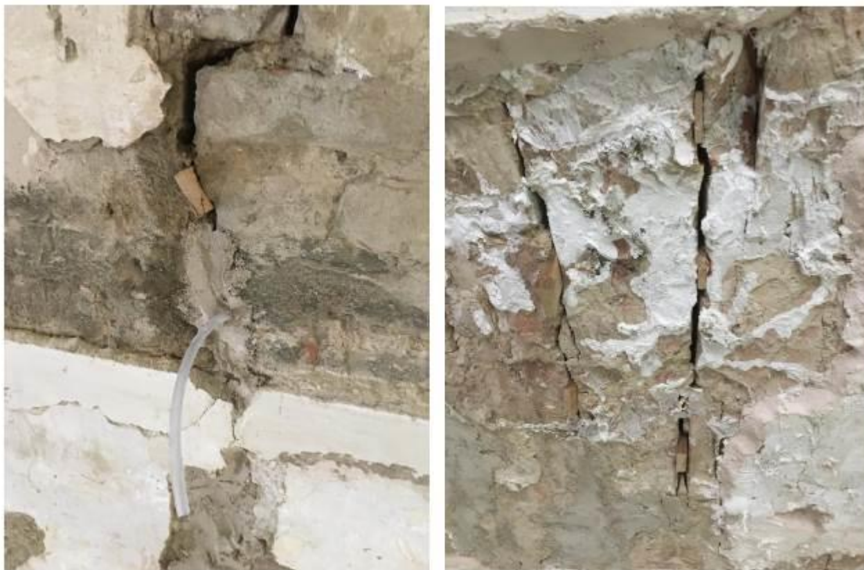
Fig. 8 - Inserimento cunei in legno duro
