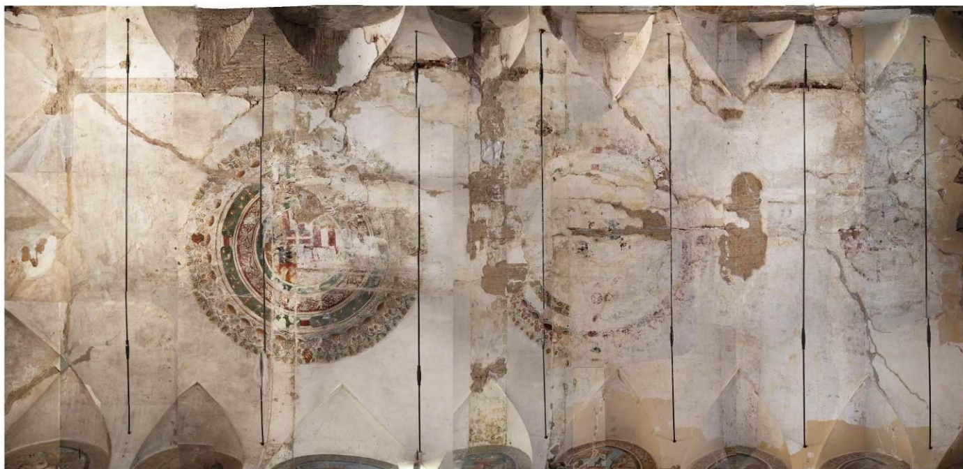
Fig. 4 - Fotopiano eseguito prima degli interventi aggiuntivi disposti dalla DL
