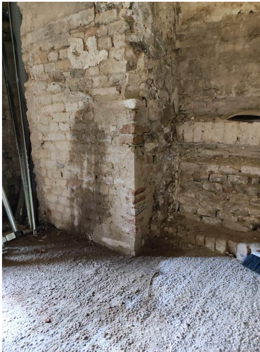
Fig. 24 – Dettagli scuci cuci parete sud – sala dello Zodiaco
