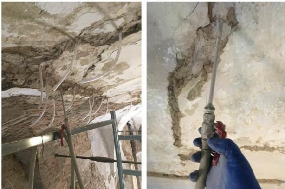
Fig. 10 - Iniezione delle lesioni
